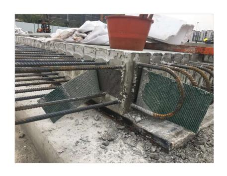
为了解决混凝土接层粘结问题,无论是桥梁构件、桥墩或浇筑铰缝及桥面铺装前毛勒缝槽口等结合部,或水泥混凝土坝、核电站、港口码头、隧道、水电站闸墩等水泥混凝土工程的施工还是加固这些工程,凿毛的目的都是为了使新老水泥混凝土之间能够形成一个整体。被凿击后的表面不但要去除浮浆还应形成凹凸麻面,而不是一个平整的毛面,只有这样新老混凝土才能黏合为一个整体。一般要使新老混凝土融合的更加结实,需要扩大其接触面积,通常情况下就需要人工来将平整的毛面打造成麻面的效果,但是这样费时费力而且增加了施工成本,而止浆带是一种新型的复合材料,可以根据现场需要制作成各种尺寸,止浆带出来的效果是整齐规则的麻面,即美观又方便还可以重复使用。宽泛的应用于桥墩浇筑,桥面铺装槽口结合部;或水泥混凝土坝、核电站、码头、隧道等混凝土工程。钢筋模板安装完毕,安装免凿毛止浆条,混凝土浇筑完后,拆除止浆带并清理干净。自采用以上措施梁场提高了施工质量,缩短了施工时间,提高劳动效率,具有安装方便,节约时间等优点。
